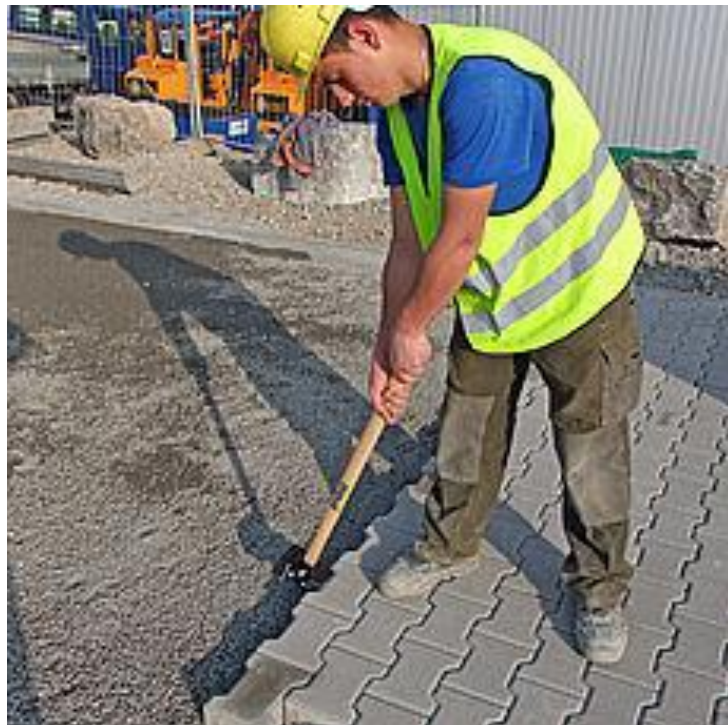
Foto N° 4: Martillo de goma para acomodar adoquines, con mango largo.
